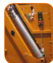
8 Vérins de compaction à l'extérieur de la trémie
